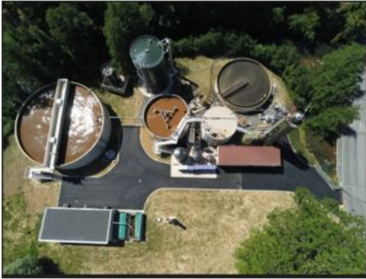
Extension de station avec méthanisation (papeterie)
